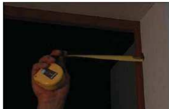
Verifica del centraggio del telaio nel vano murario
