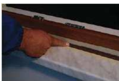
Rifinitura del giunto di sigillatura
