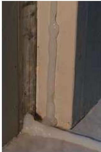
Raccordo tra il cordolo verticale ed orizzontale in corrispondenza del davanzale
