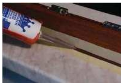
Siliconatura del giunto sul davanzale
